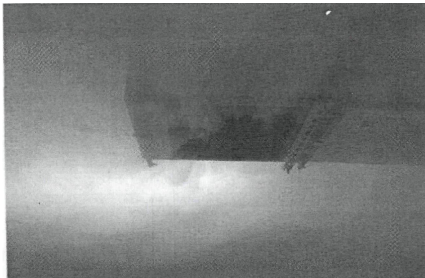
Фото 1. Вытяжная решетка, на которой наблюдается явление затягивания чистого воздуха
