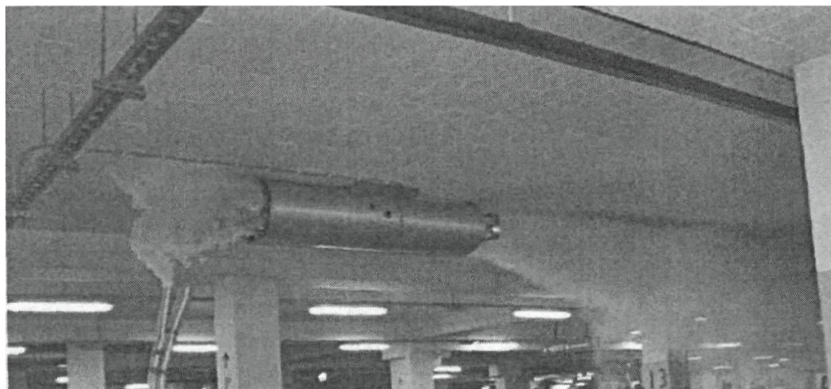
Фото 5. Визуализация воздушного потока, возникающего под действием струйного вентилятора, оснащенного дефлектором
