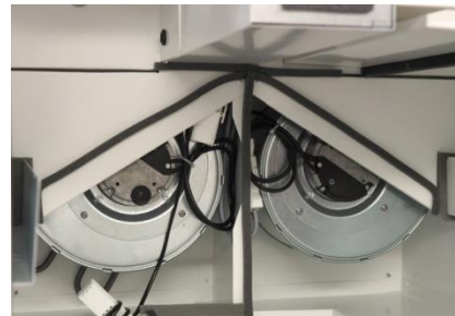
Kuva 10. Lämmöntalteenottokennon poistaminen.
