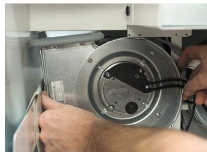
Kuva 11. Puhaltimen irrotus.
