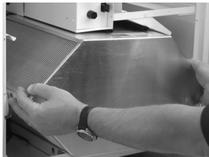
Kuva 10. Lämmöntalteenottokennon poistaminen.
