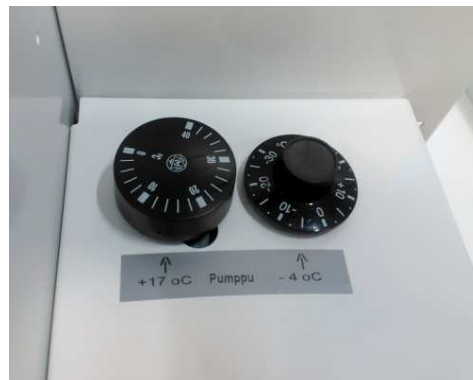
Kuva 13. Sähkölaatikon termostaatit
